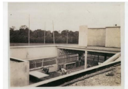
サヴォア邸建設現場 1930年頃。撮影/前川國男 前川建築事務所蔵
